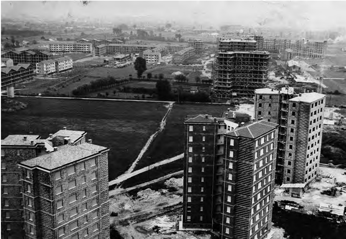
Foto 5 - Edificazione abitazioni quartiere Vallette, scheda LV01 http://www.immaginidelcambiamento.it/schede , di Torino, 1957
