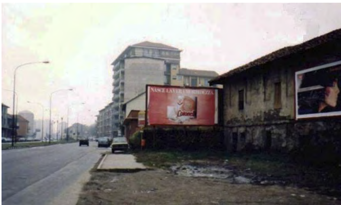
Foto Storica: Cascina in degrado, area sterrata Data: Anni 80
