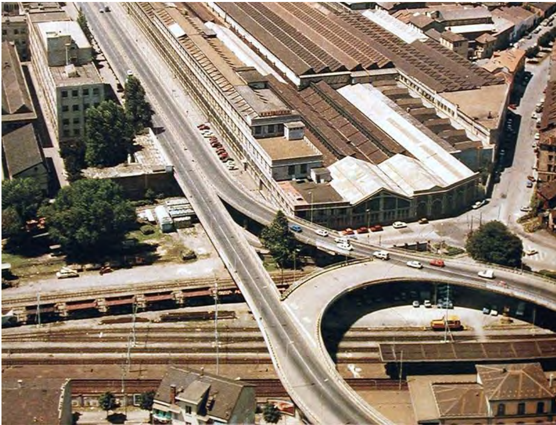
Foto Storica: Sopraelevata di corso Mortara sulla stazione Dora, verso Officine Savigliano e Ferriere Fiat Data: Anni 80 Fonte: CDS 5
