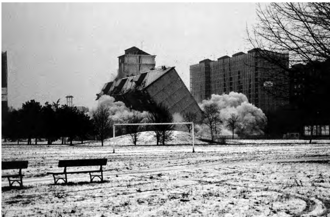
Foto Storica: Demolizione edificio a torre in via Garrone Data: 2003 Fonte: EUT10
