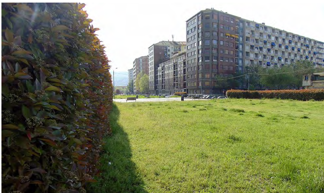
Foto Attuale: Parco Clessidra, zona Spina 1 (ferrovia interrata)
