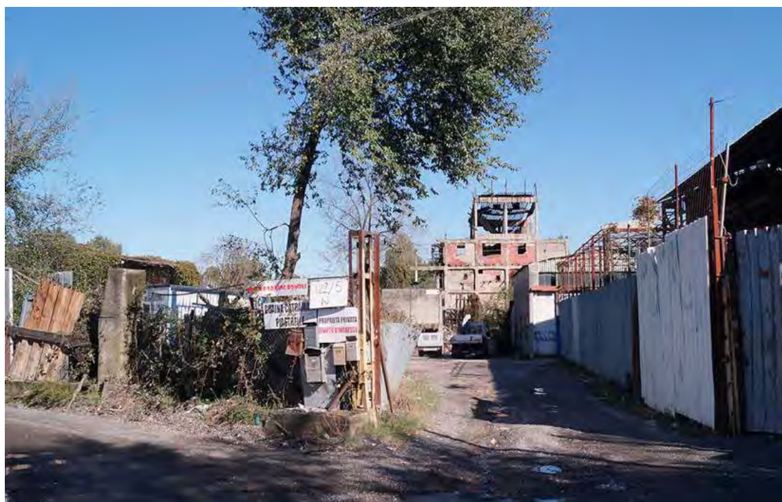
Foto Attuale: Azienda piastrelle abbandonata Data: 2015 Fonte: Luca Davico
