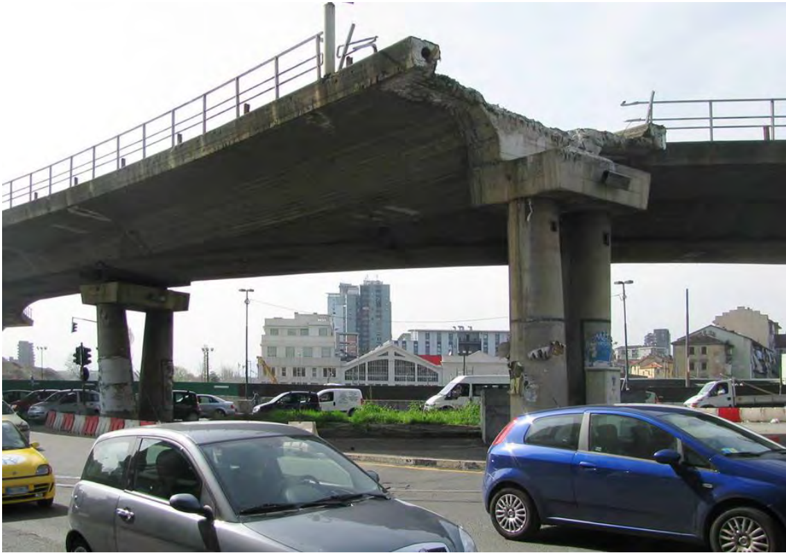
Foto Storica: Smantellamento sopraelevata piazza Baldissera, sullo sfondo stazione Dora Data: 2007 Fonte: Luca Staricco
