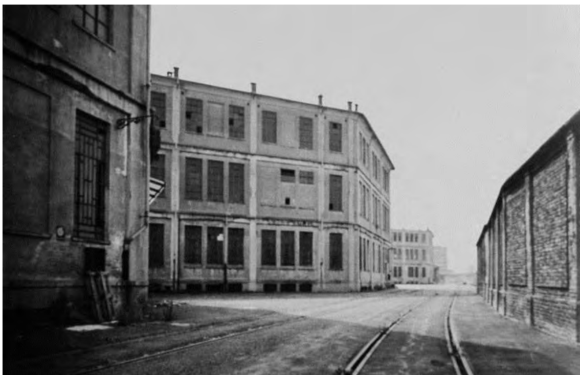
Foto Storica: Ex magazzini Docks Piemontesi Data: anni 90
