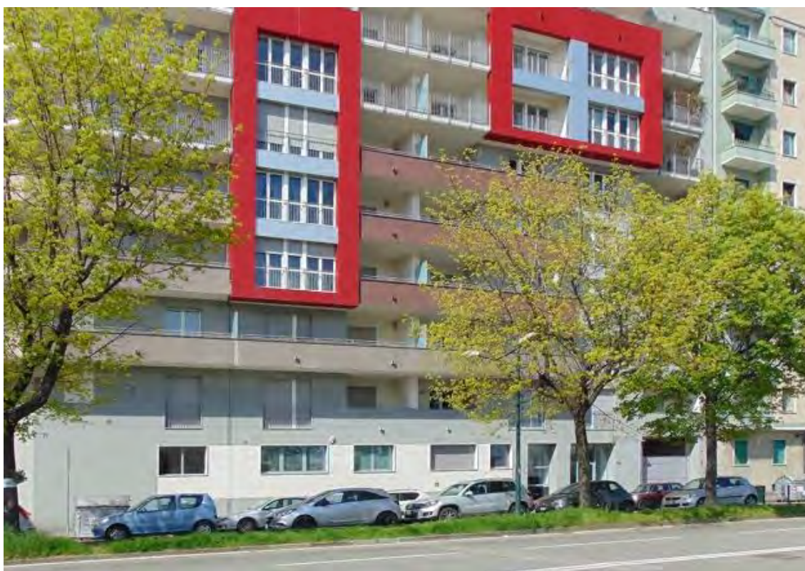
Foto Attuale: Edificio residenziale Data: 2018 Fonte: Chiara Donno
