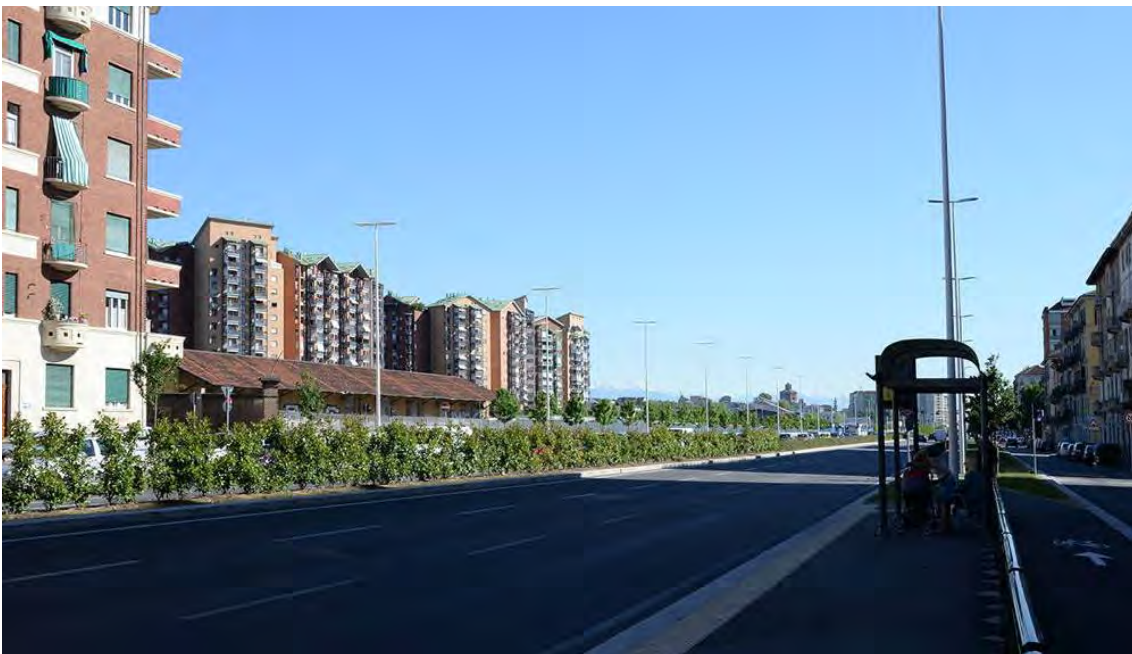
Foto Attuale: Abbassamento del ferro e apertura di corso Principe Oddone per la viabilità su gomma con dotazione di percorsi pedonali, pista ciclabile e verde stradale Data: 2017 Fonte: Elena Cardino
