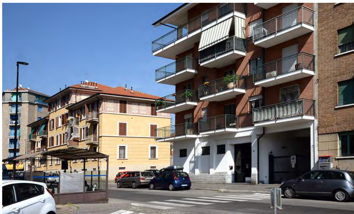
Foto Attuale: Edifici di civile abitazione. Edificazione compatta in tutta la zona
