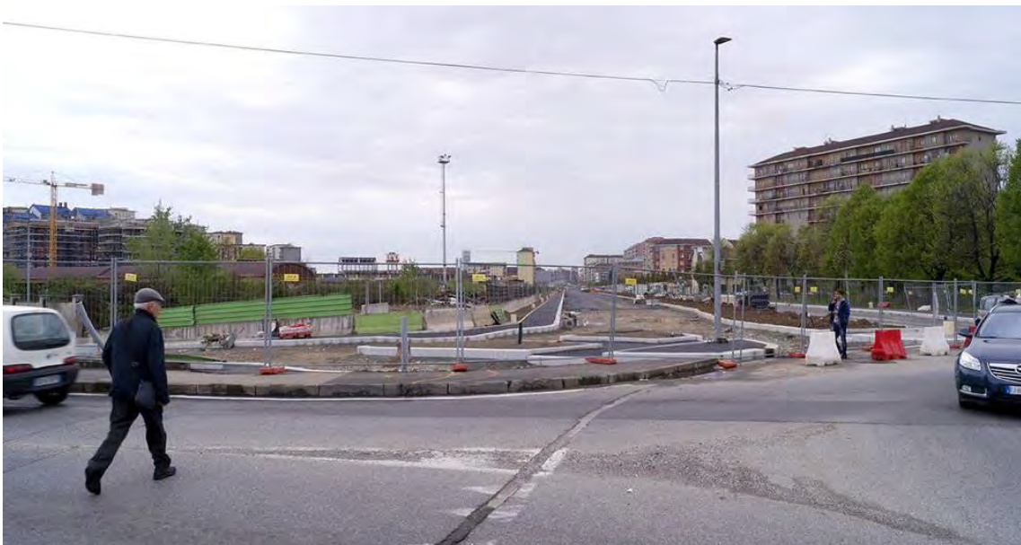
Foto Attuale: Vista dalla rotonda di via Breglio verso l'area di Spina 4 (ferrovia interrata)
