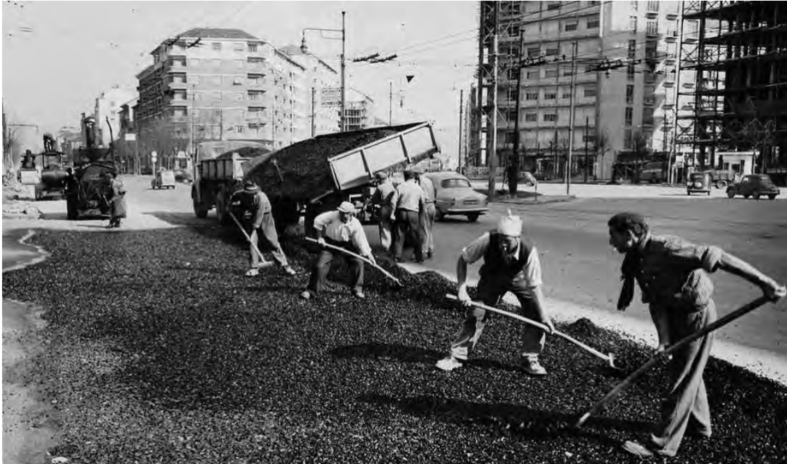
Foto Storica: Asfaltatura piazza Rivoli Data: 1956
