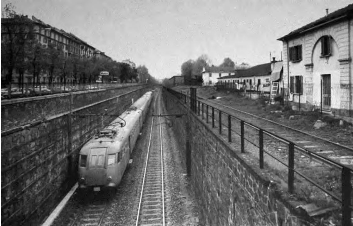
Foto Storica: Trincea ed edifici ferrovie Data: anni 80 Fonte: Archivio Storico GTT
