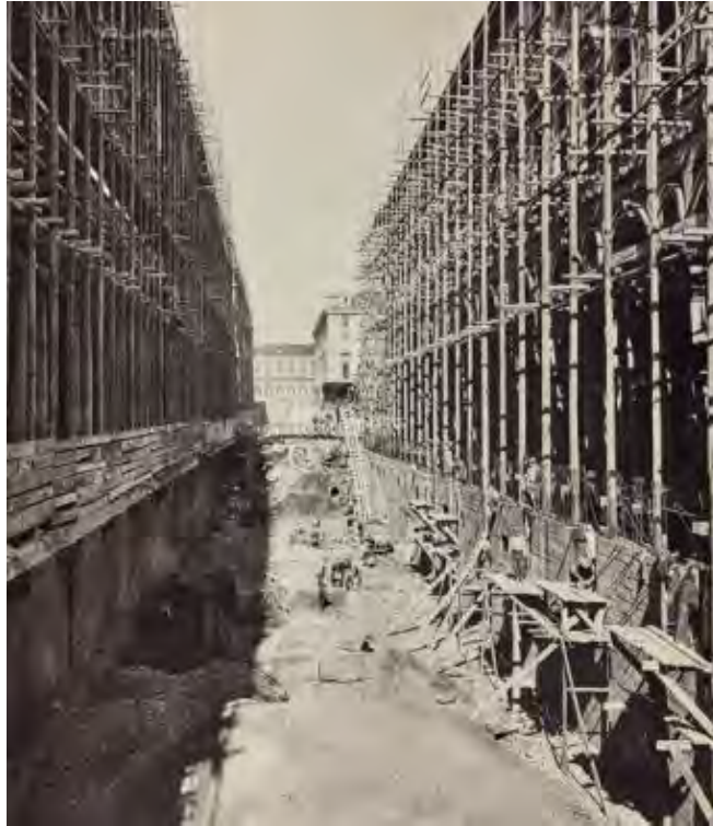
Figura 35 - Lavori per la costruzione della nuova via Roma, Torino, https://www.alinari.it/it/dettaglio/FVQ-F-029851-0000?search=c3f3fe322c936d0a66d3aded8729c236&searchPos=9 , Gabinio Mario, 1930 ca.
