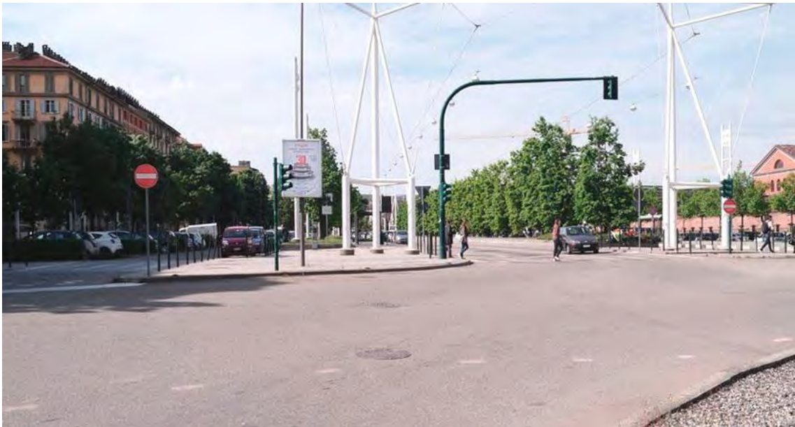
Foto Attuale: Viale Spina 2 (ferrovia interrata) Data: 2015 Fonte: Angela Caterini
