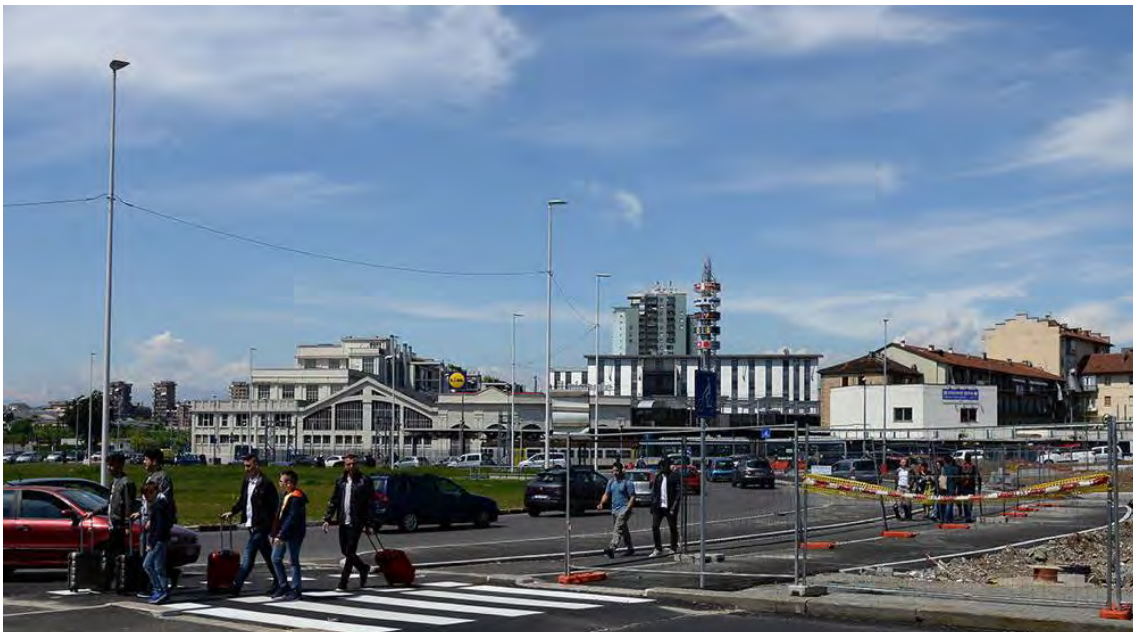
Foto Attuale: Piazza Baldissera con rotonda e percorsi ciclopedonali; lavori in corso verso corso Venezia Data: 2017 Fonte: Elena Cardino
