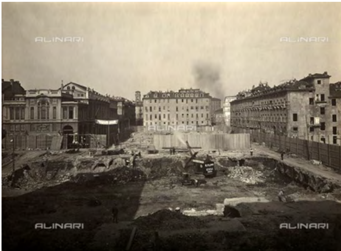
Foto 36 - Via Roma a Torino in fase di demolizione, https://www.alinari.it/it/dettaglio/FVQ-F-000782-0000?search=1d61a3478cd7f101d3d1fdafc35d9ee7&searchPos=126 , Gabinio Mario, 1931 ca
